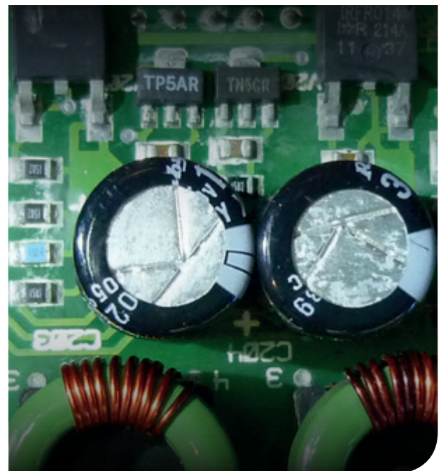
- In het midden zijn twee condensatoren van een frequentieregelaar te zien
